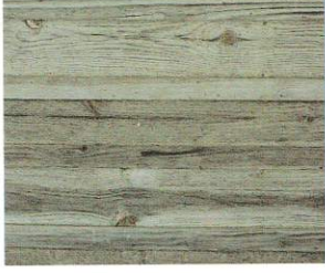
Bardage de bois et couvre-joint. L'Herbe
