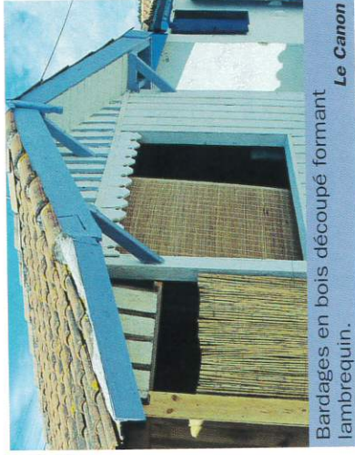
Bardages et couvre-joints en bois découpé. L'Herbe
