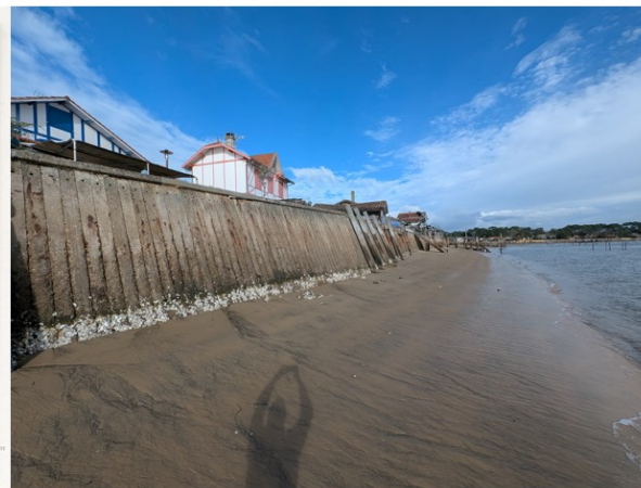
Figure 1-21 Exemple d'exhaussement de la crête d'ouvrages pour faire face à l'augmentation des niveaux d'eau au Petit Piquey (haut) et à Piraillan (bas).
