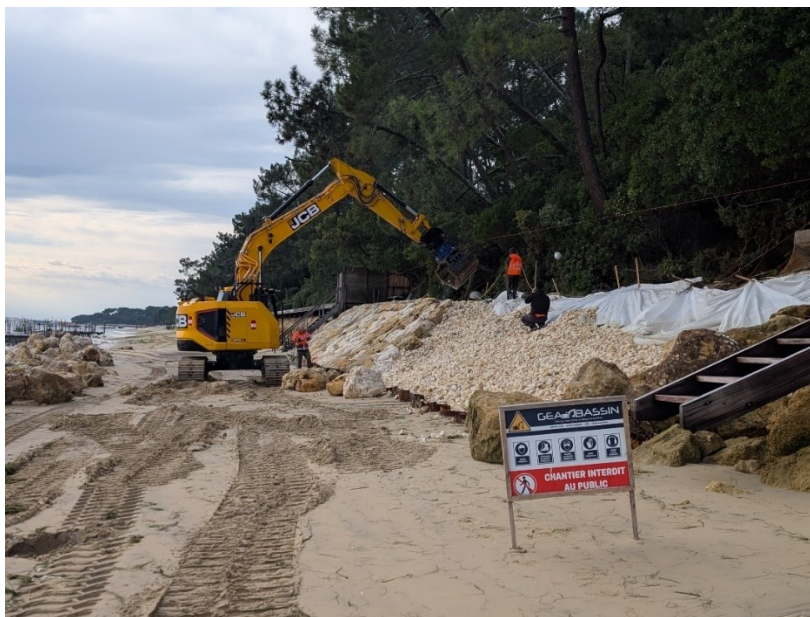
Figure 1-15 Exemple de travaux en cours pour réhabiliter un perré en enrochement.
