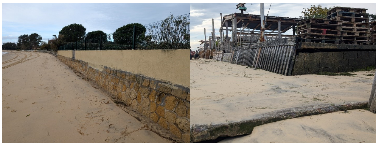
Figure 1-14 Exemple d'ouvrages longitudinaux représentant la nature composite de leur structure avec des exhaussements (gauche au Claouey) ou des protections diverses (droite, l'Herbe) sur des ouvrages ou remblais existants.
