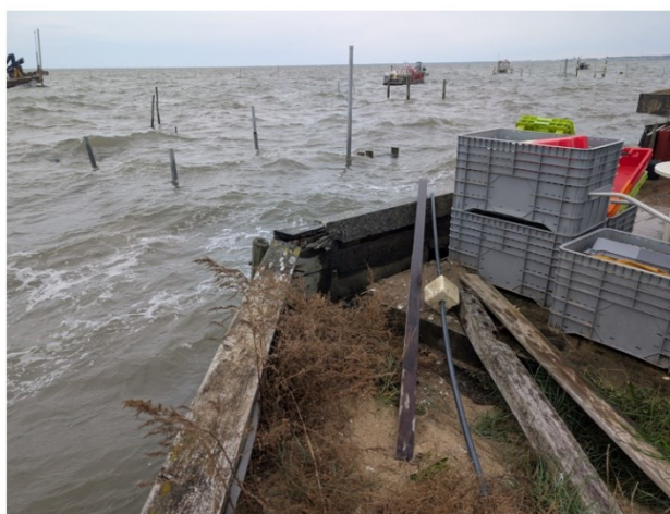
Figure 1-16 Exemple (1) d'attaque par les vagues et de surverse ponctuelle au droit d'un tronçon dégradé. Ces sollicitations répétées fragilisent l'ouvrage et peuvent réduire sa capacité à contenir l'érosion et la submersion.
