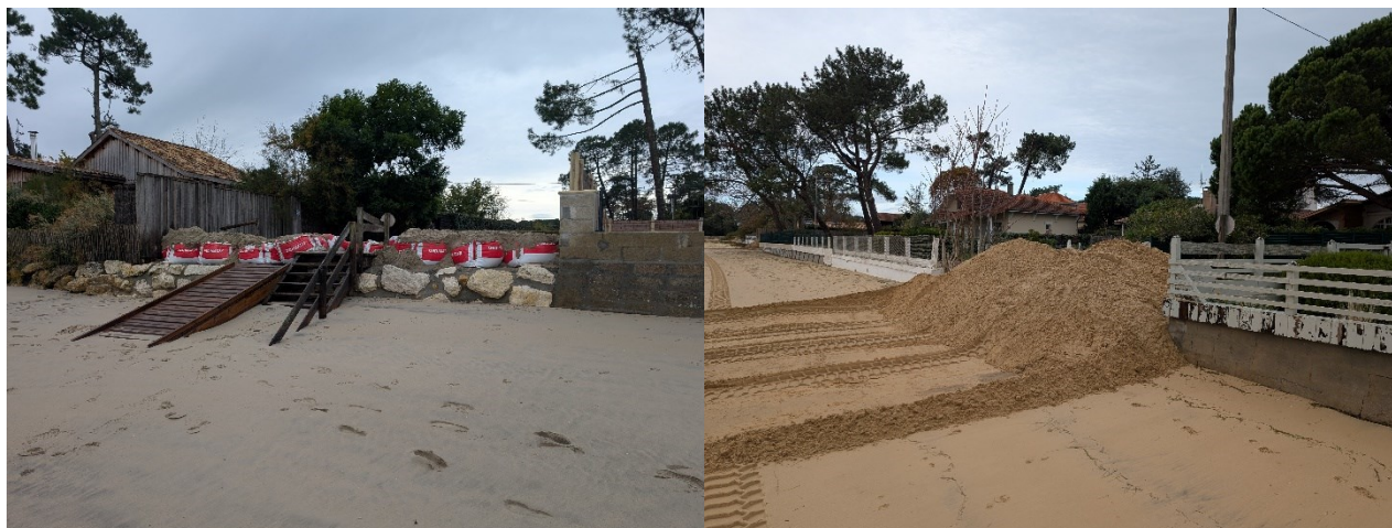
Figure 1-32 Deux exemples au Claouey d'utilisation de sac de sables et du sable de la plage contre la submersion marine (comblement d'entrée de zones basses).
