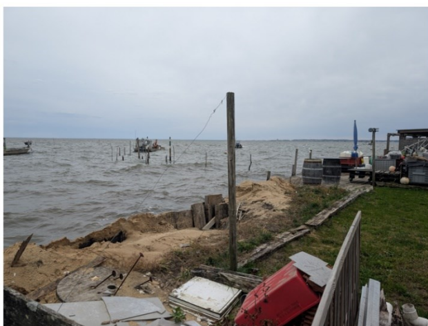
Figure 1-16 Exemple (1) d'attaque par les vagues et de surverse ponctuelle au droit d'un tronçon dégradé. Ces sollicitations répétées fragilisent l'ouvrage et peuvent réduire sa capacité à contenir l'érosion et la submersion.
